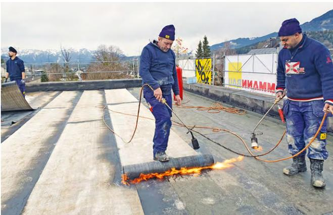
Die Dachabdichtung erfolgte mittels dreilagiger Bitumenbahnen.
