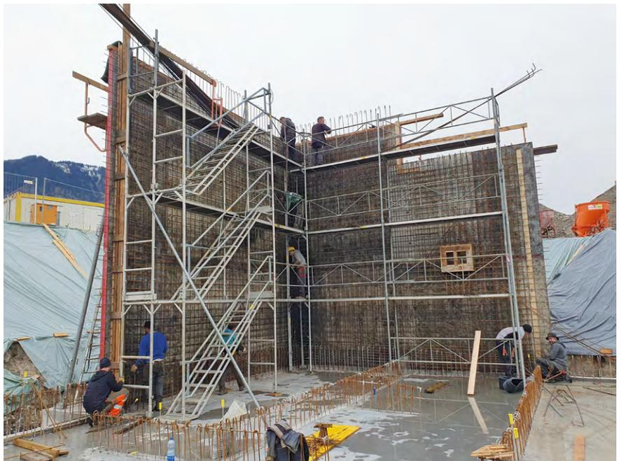
Nach dem Baugrubenaushub konnte mit dem Fundament und den ersten Wänden begonnen werden.
