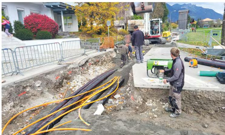
Nahwärme-Hauptleitung mit LWL-Verbundleitungen und VKW-Leerverrohrung
