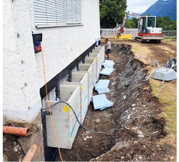
Nach den Abdichtungsarbeiten wurden neue Lichtschachtelemente versetzt.
