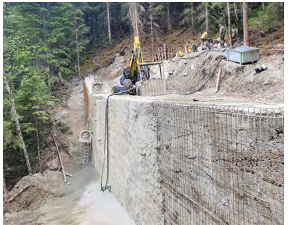
Spritzbetonummantelung der Sperrbauwerke
